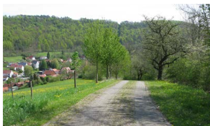
Betonpflasterweg im Flurbereinigerungsverfahren Sickerode; Landkreis Eichsfeld. (Foto: TMIL)
