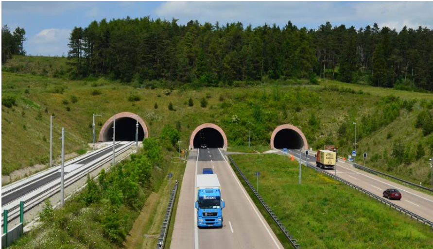
ILE unterstützt Infrastrukturgroßprojekte; hier A71 und ICE-Neubaustrecke bei Behringen. (ALF Gotha)
