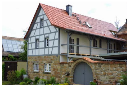
Sanierter Fachwerkhof in Hainbücht, Saale-Holzland-Kreis. (Foto: ALF Gotha)
