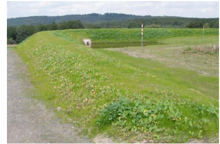
ILE reagiert auf die Folgen des Klimawandels – Regenrückhaltebecken im Flurbereinigungsverfahren Teufelstal. (ALF Gera)
